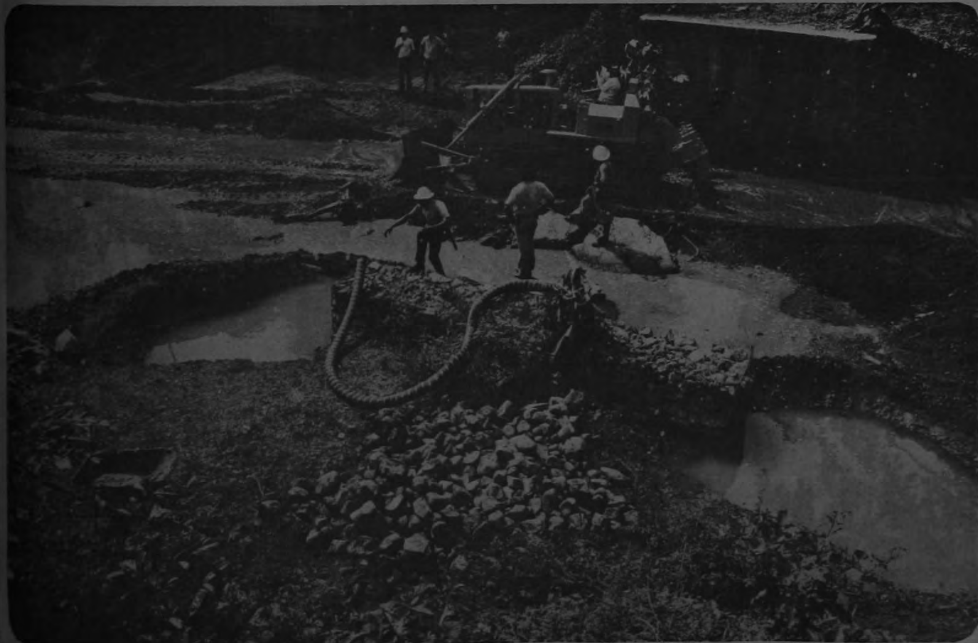
CUANDO SE CONSTRUIA EL PUENTE RIO DOMINICAS CAMINO SAN MIGUEL DE RIO BLANCO. TRACTOR NUEVO MUNICIPAL APORTE DE MATERIALES Y MANO DE OBRA, LOS TRABAJOS ESTAN CONCLUIDOS.
