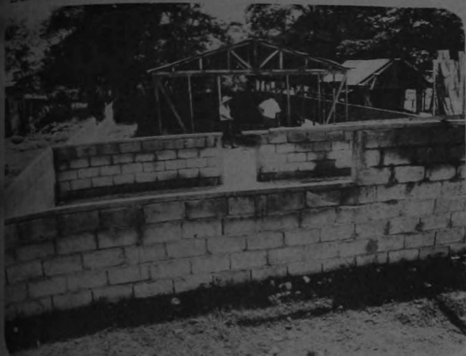
CONSTRUCCION DEL SALON COMUNAL DE RIO BLANCO DE JICARAL. APORTE MUNICIPAL DE ₡ 10.000.00. APARECE EL EJECUTIVO MUNICIPAL INSPECCIONANDO LA OBRA CON EL DIRIGENTE COMUNAL DE ESE LUGAR MIGUELITO DURON JIMENEZ. DICIEMBRE 1975.
