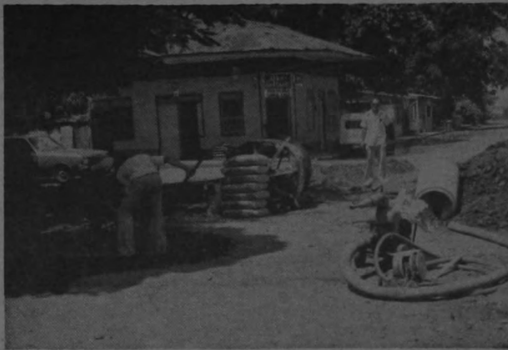
Los trabajos subterráneos de preferencia para luego iniciar los asfaltados.
